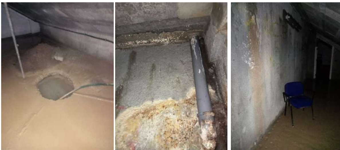
fotos – vista pelo interior do alçado poente – nível freático elevado, infiltrações e existência de um poço antigo
