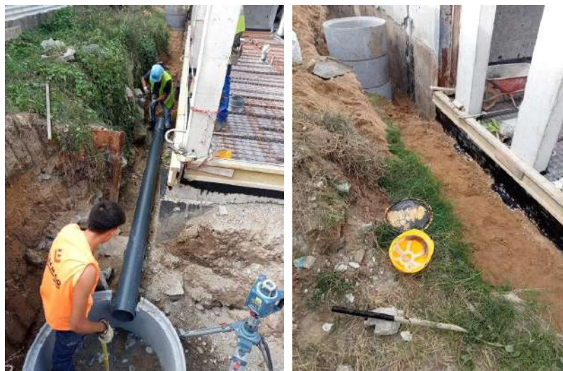
fotos – abertura de caboucos para execução de rede de águas pluviais pelo exterior
