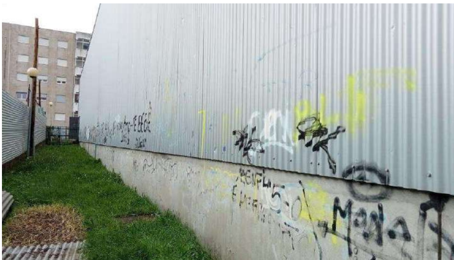
foto – vista pelo exterior do alçado poente - rebocos existentes danificados e com fissurações
